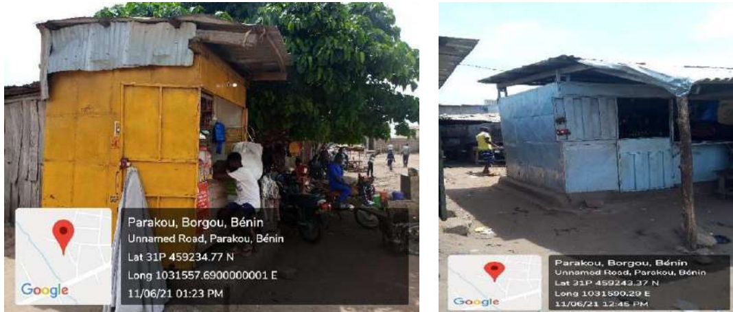
Planche 5 : Kiosques métalliques sur le site d'accueil du projet
