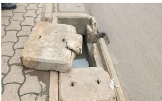
Caniveaux ouverts du fait de dalles cassées sur l'axe Carrefour SOBREBRA – Carrefour le Béliér
