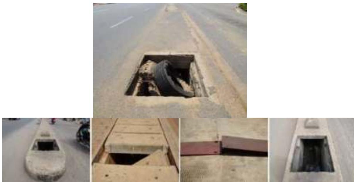
Planche 9 : État des ouvrages d'assainissement sur les axes à aménager
