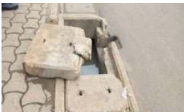
Caniveaux ouverts dufait de dalettes cassées sur l'axe Carrefour SOBREBRA – Carrefour le Bélier
