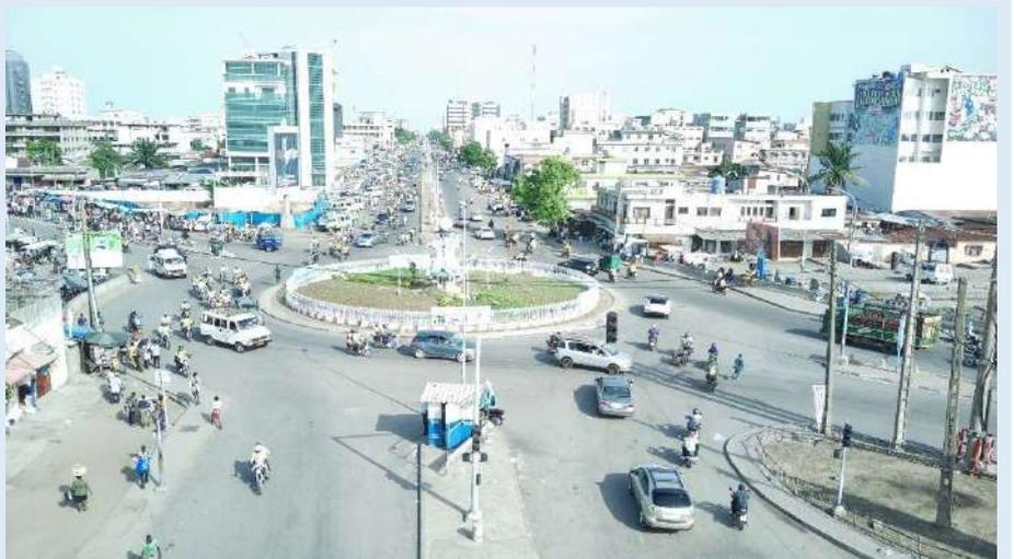
Avec un rayon giratoire de 26,50m, ce carrefour est classé parmi les grands giratoires. Avec une largeur de 11,50m pour l'anneau, et une voie d'entrée et de sortie de 10m ; ce giratoire est mal conçu et ne répond pas normes de CEREMA. Il est retenu de :
