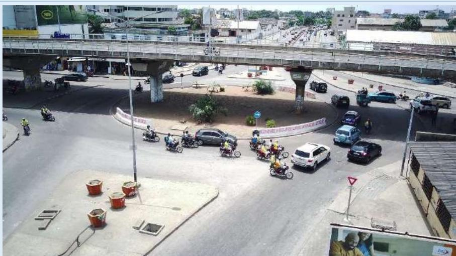
Avec un rayon giratoire de 25m, ce carrefour est classé parmi les grands giratoires. Avec une largeur de 10m pour l'anneau, et une voie d'entrée et de sortie de 10m ; ce giratoire répond parfaitement aux normes du CEREMA
