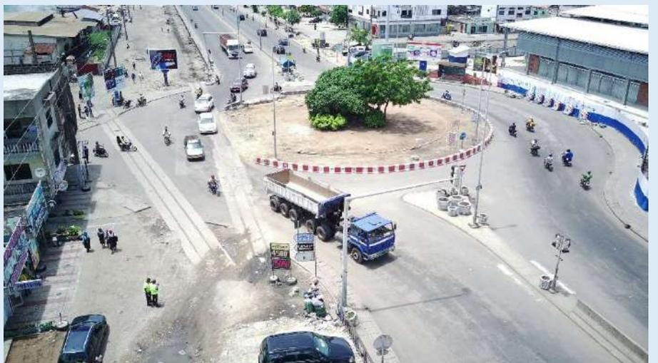
Avec un rayon giratoire de 29m, ce carrefour est classé parmi les grands giratoires. Avec une largeur de 12m pour l'anneau, et une voie d'entrée et de sortie de 10m ; ce giratoire est mal conçu et ne répondent pas normes de CEREMA. Il est retenu de :
