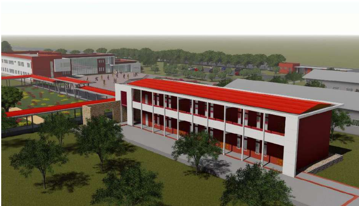
Photo 5 : Vue partielle du bloc de salles de classes projeté
