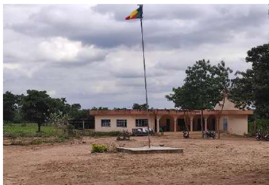
Photo 16 : Bloc administratif du Lycée
