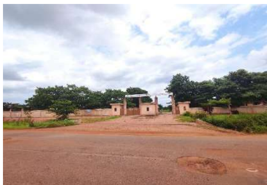
Photo 13 : Entrée principale du Lycée
